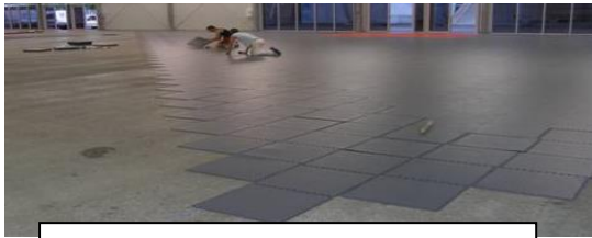
Pose en escalier
